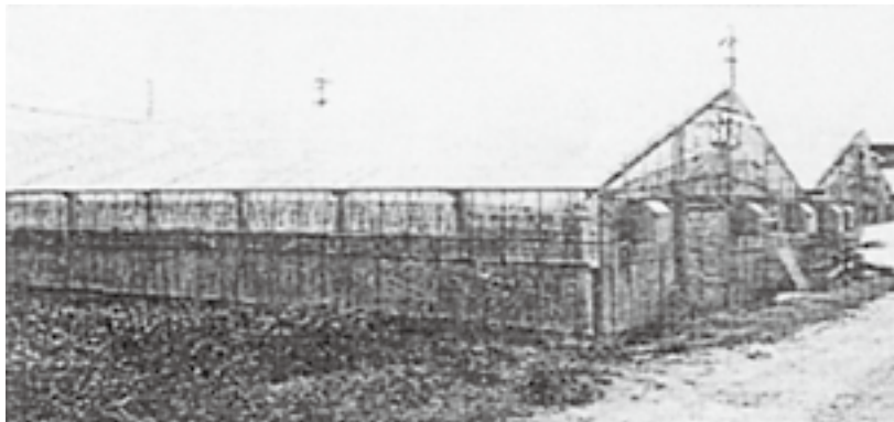
▲当時の鉄骨のハウス（逆川地区）
