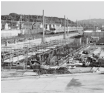
▲工事が進む新駅
