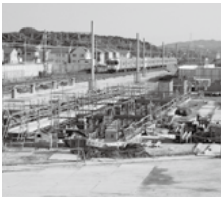
▲工事が進む新駅
