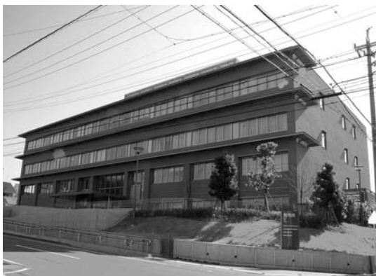
▲名古屋地方裁判所岡崎支部
