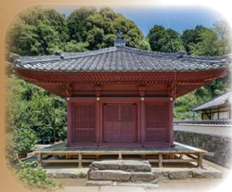
肖影堂組立工事（本光寺）
