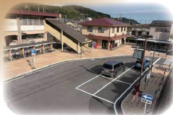
三ヶ根駅西口整備工事
