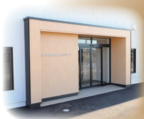
高齢者生きがいセンター移転改修工事
