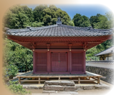
肖影堂組立工事（本光寺）
