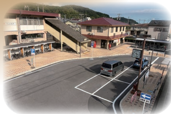
三ヶ根駅西口整備工事
