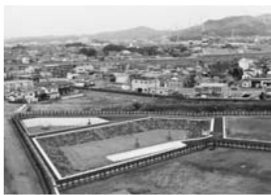
▲3月に完成した一般廃棄物最終処分場
