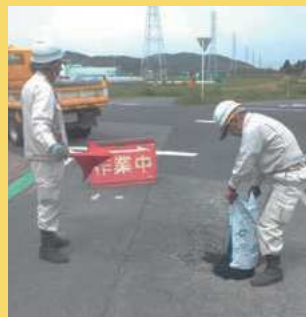
②町道路上の舗装穴埋め
