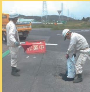
②町道路上の舗装穴埋め
