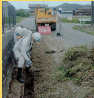
③側溝内の清掃
