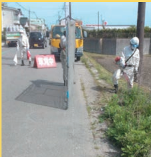
①町道路敷の草刈り
