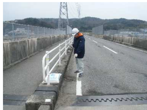
写真-3.4 目視点検状況
