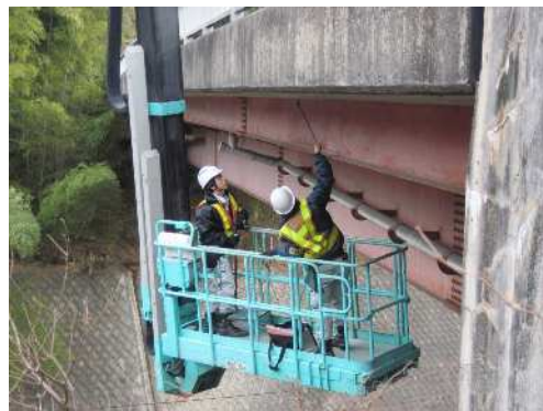
写真-3.2 専門業者による点検
