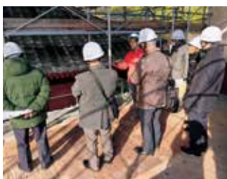
本光寺肖影堂改修現場
