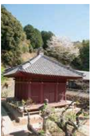
修理が完了した肖影堂
