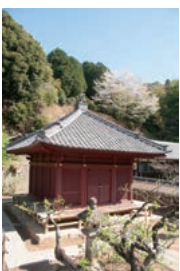
修理が完了した肖像堂
