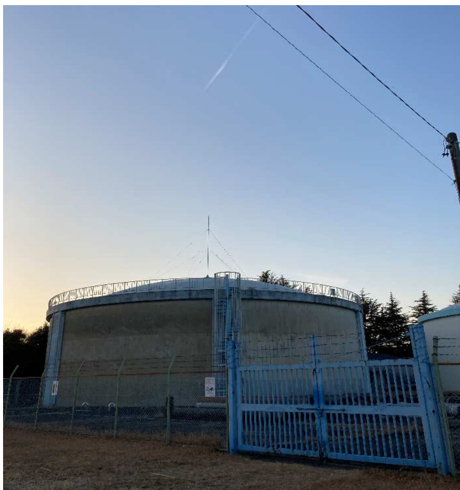
写真：永野配水場（永野区墓所山地内）
