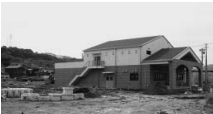
建設中の一般廃棄物最終処分場（六栗地区）
