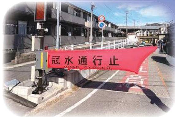
仲田ガード自動閉鎖機設置工事
