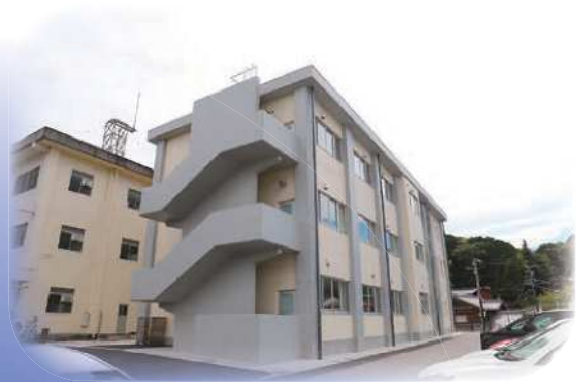
深溝小学校校舎増築
