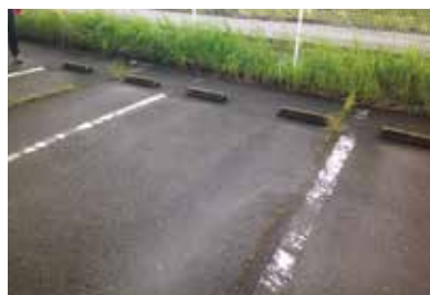
設置前の駐車場（町民プール）
