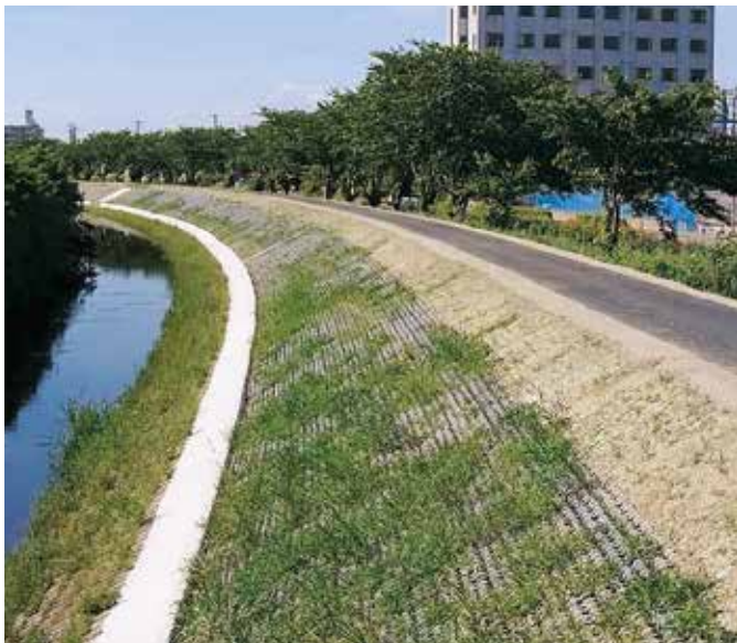
堤防舗装された幸田駅西の広田川
