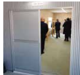
幸田駅西の防災倉庫内
