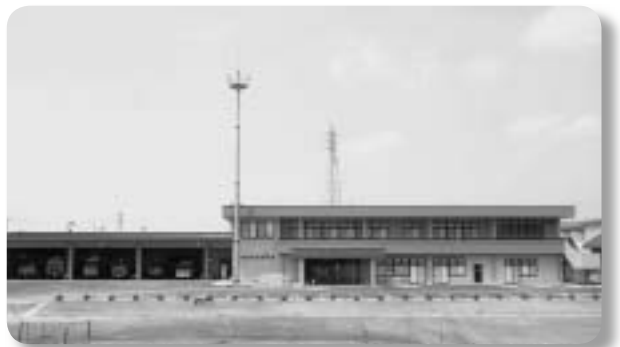
今年完成した消防庁舎
