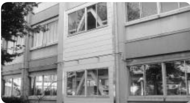
耐震補強が行われた豊坂小学校
