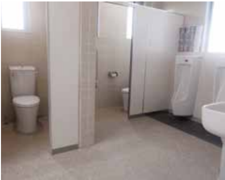
洋式化に合わせて乾式化されたトイレ
