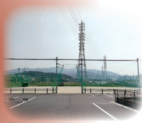
岩堀住民広場整備
