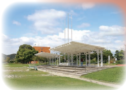
中央公園休憩所整備
