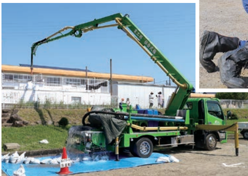
コンクリート圧送車による排水
