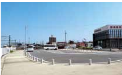
整備が進む幸田駅前
