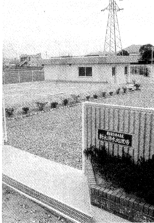
▲新永配水処理場
