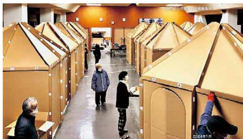
段ボール製インスタントハウスを公民館に設置する様子（輪島市）
