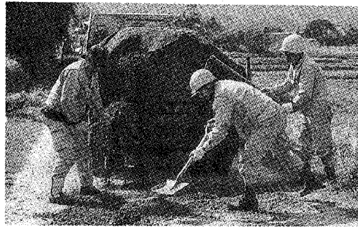
しんせつ班による舗装作業
