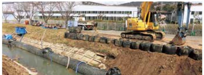
広田川の堤防工事（六栗地内）
