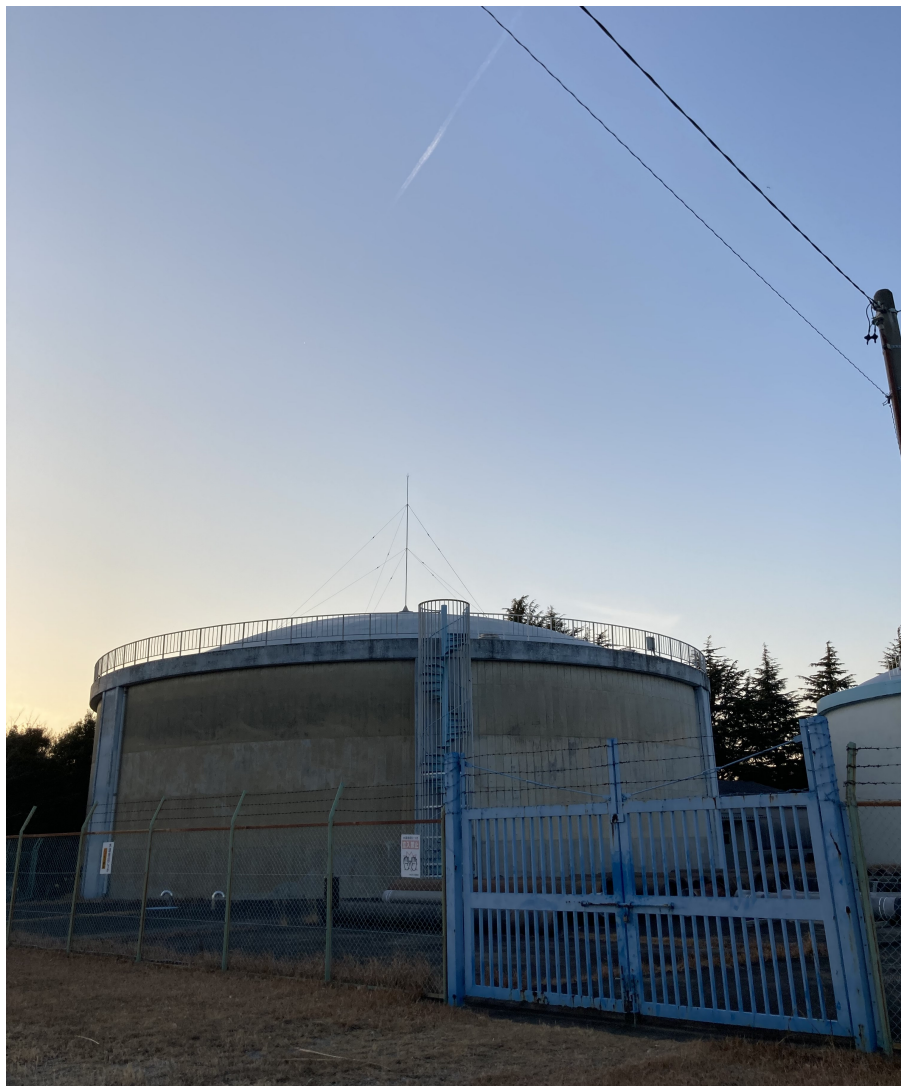
写真：永野配水場（永野区墓所山地内）
