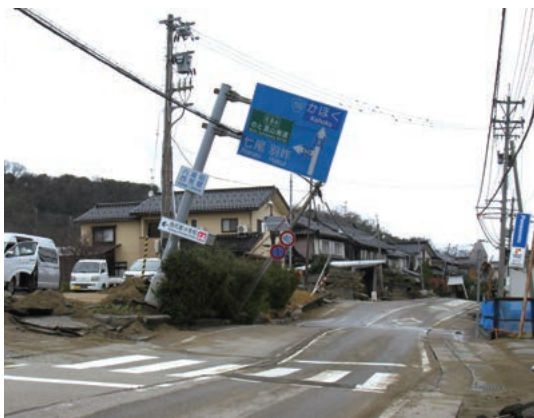
幸田町職員撮影：傾いた道路看板
