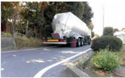
拡幅が急がれる県道蒲郡碧南線
