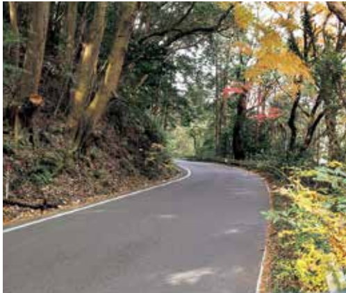
整備が望まれる生平幸田線(大井池付近)
