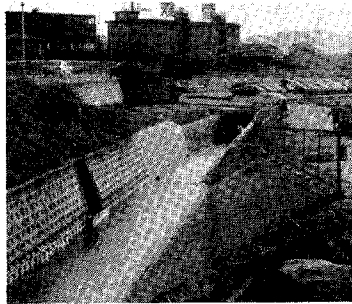
田多美川下水路
