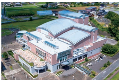
町民会館修繕
