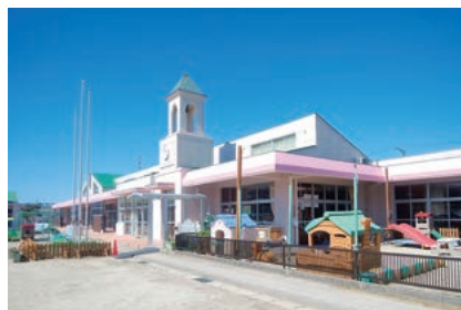
坂崎保育園改修
