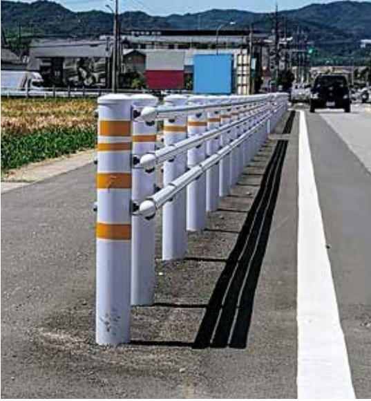
歩道修繕に合わせガードパイプを設置
