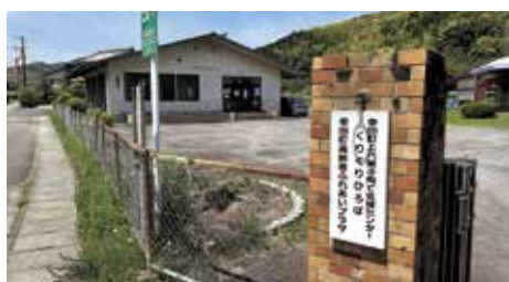
事務所転用予定施設
