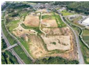
整備中の須美前山工業団地
