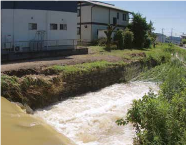
越水で、堤防道路がえぐられた尾浜川 (令和5年6月3日撮影)
