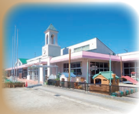
坂崎保育園改修
