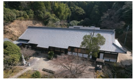
2022年に復旧工事を終えた本光寺本堂
