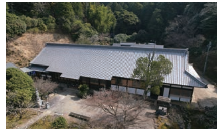
2022年に復旧工事を終えた本光寺本堂
