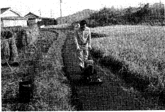
▲ 道路舗装工事
