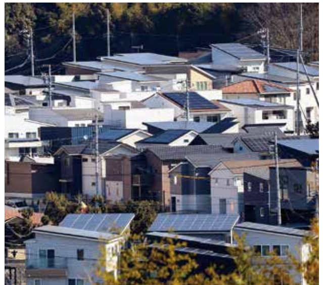
設置が進む太陽光パネル
