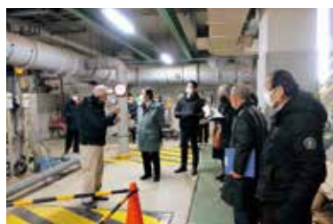
蒲都市下水道浄化センター
