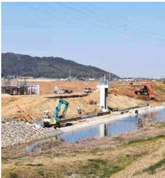
改修整備が進む広田川（菱池排水機場付近）
