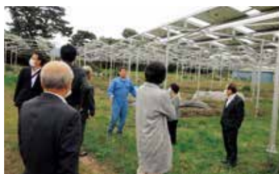
畑に設置されたソーラーパネル
