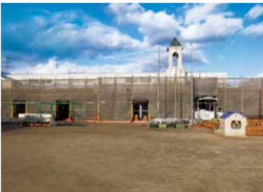
大改修中の坂崎保育園
