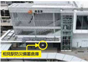
相見駅東口の防災備蓄倉庫
