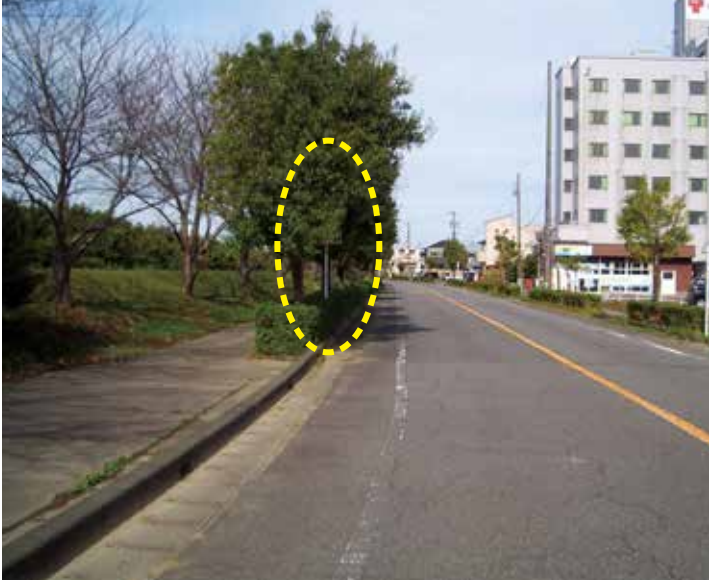
道路標識が樹木で見えなくなった町道
