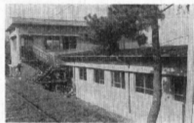
仕上工事中の母子健康センター
