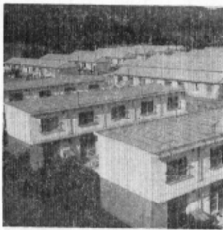
完成した県営住宅
