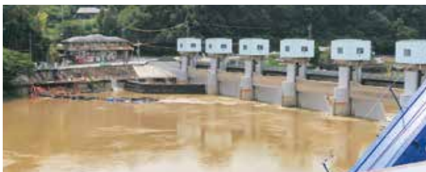
明治用水頭首工漏水箇所
