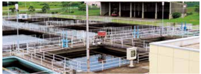
県営幸田浄水場
