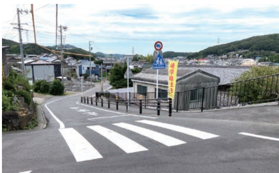
町道北広畑天上坂1号線 道路改良事業
