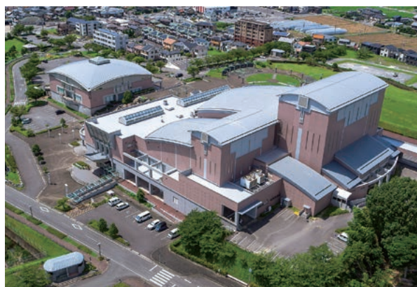
町民会館修繕
