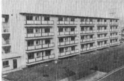
（完成した移転就職者用宿舎）
