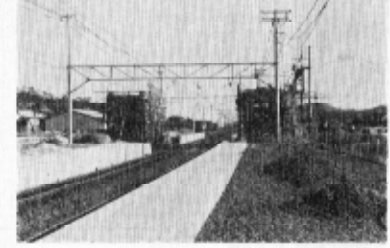
（新駅建設工事）
